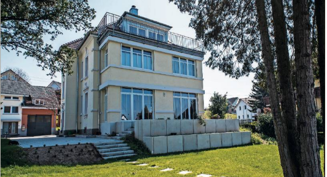
In neuem Glanz: „Oftmals ist das Potenzial, das eine Immobilie bietet, nicht auf Anhieb erkennbar“, sagt BAU 72-Geschäftsführer Jürgen Seiler. Foto: Gerhard Dinger/BAU 72
