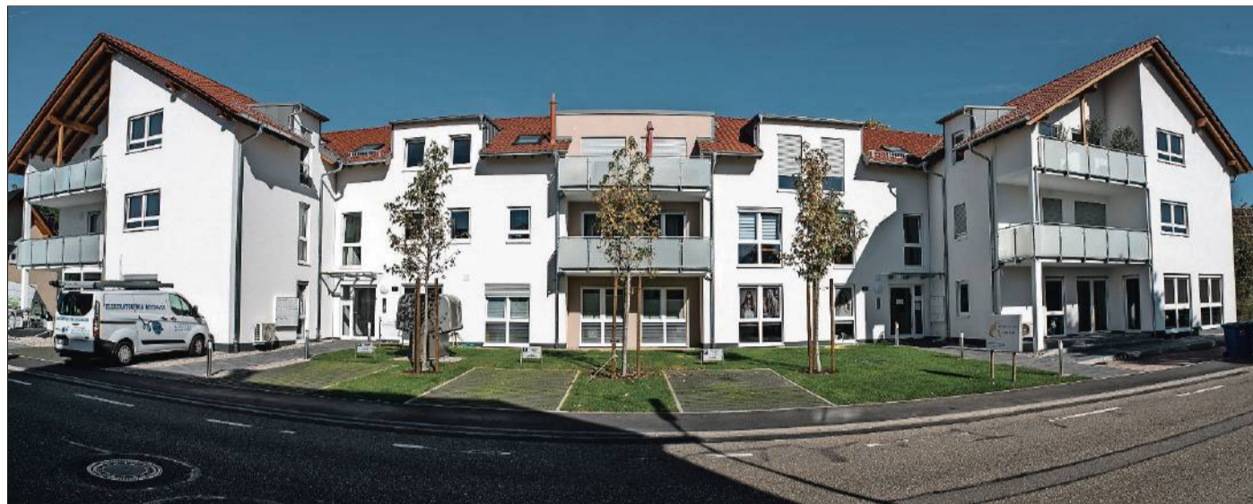
Mindestens ein Geschoss in Mehrfamilienhäusern von BAU 72 wird komplett barrierefrei ausgeführt. Foto: Gerhard Dinger/BAU 72
